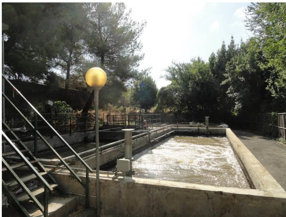
Figura 14 – impianto di depurazione esistente in comune di Albenga – loc. Bastia
